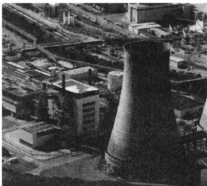
Первая в Великобритании атомная электростанция. Колдер-холл
